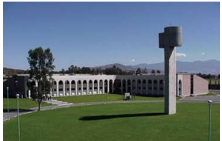
Edificio del área de mecánica del CNAD
