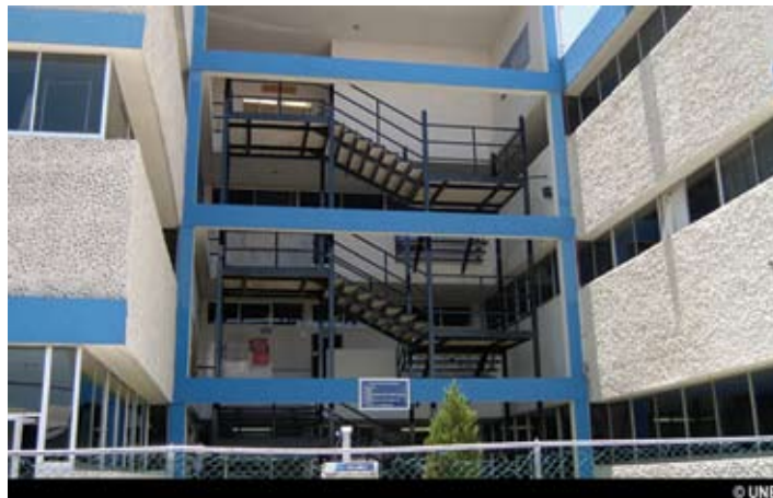
Instalaciones de la UNES
