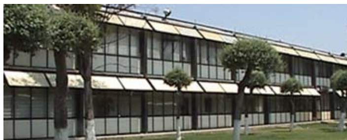
Instalaciones del CMP+L
