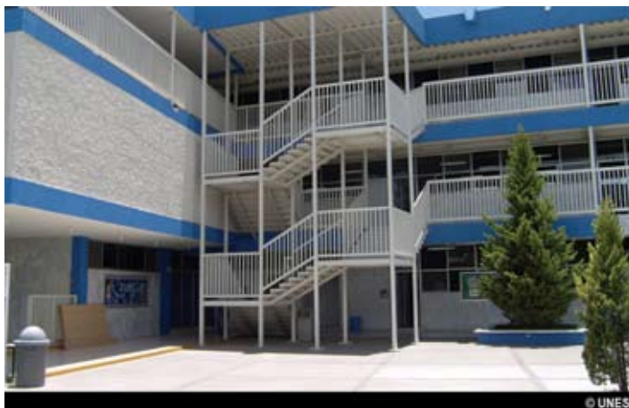
Instalaciones de la UNES
