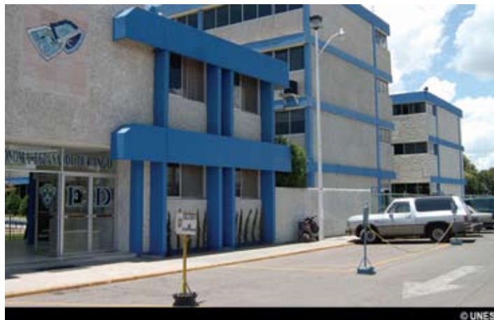
Instalaciones de la UNES
