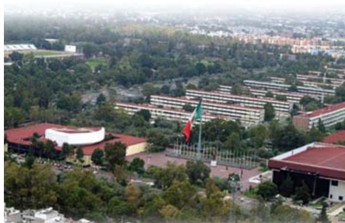
Instalaciones del IPN
